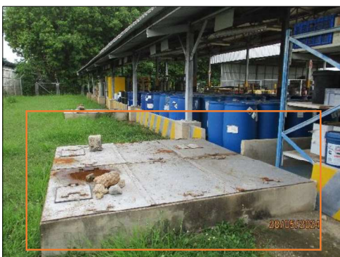
ภาพถ่ายที่ 2.2-12 บ่อรับน้ำปนเปื้อนบริเวณพื้นที่จัดเก็บสารเคมี
