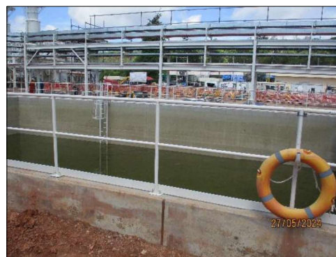
ภาพถ่ายที่ 2.2-15 บ่อกักเก็บน้ำฝนในหลุมเจาะผลิต
