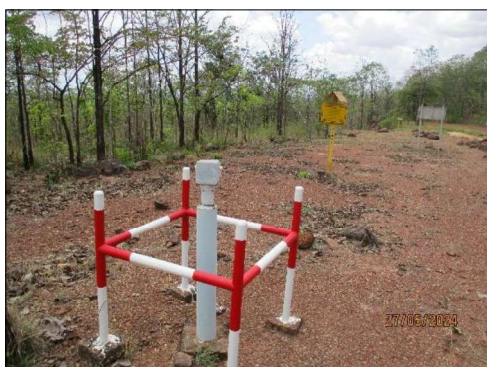
ภาพถ่ายที่ 2.2-29 จุดตรวจสอบการผูกเรือนของผิวท่อ (Cathodic Protection Test Point)
