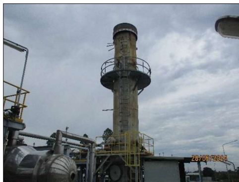
ภาพถ่ายที่ 2.2-17 Thermal Oxidizer (TOX)
