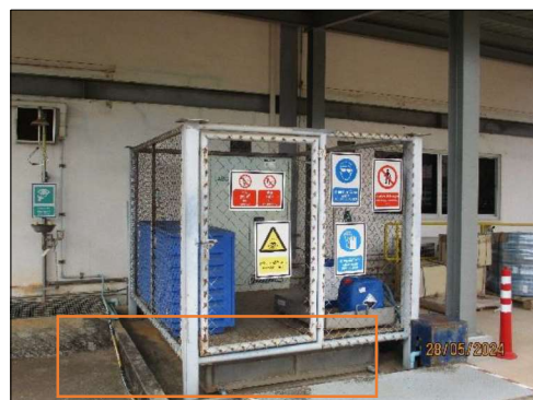
ภาพถ่ายที่ 2.2-12 บ่อรับน้ำปนเปื้อนบริเวณพื้นที่จัดเก็บสารเคมี
