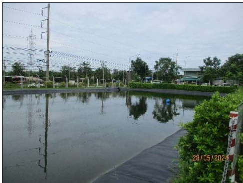
ภาพถ่ายที่ 2.2-16 ป่อกักเก็บน้ำฝนและติดตามตรวจสอบคุณภาพน้ำภายในบริเวณสถานีผลิตก๊าซ
