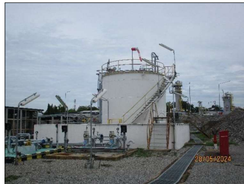
ภาพถ่ายที่ 2.2-11 คันคอนกรีตล้อมรอบถังคอนเดนเสท
