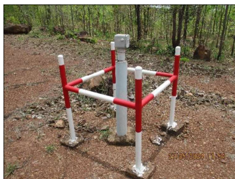
ภาพถ่ายที่ 2.2-29 จุดตรวจสอบการผูกเรือนของผิวท่อ (Cathodic Protection Test Point)
